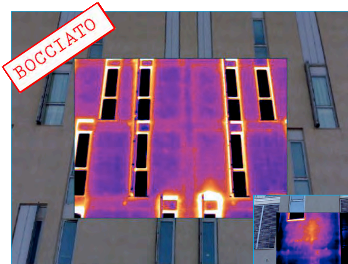
Edificio residenziale pubblico, facciata Nord Est
