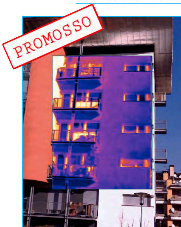
Facciate sud ovest
