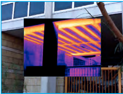
Particolare sede Comune
