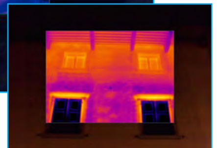
Particolare della facciata, mansarda, lato sud
