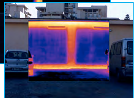
Particolare struttura muraria, nord
