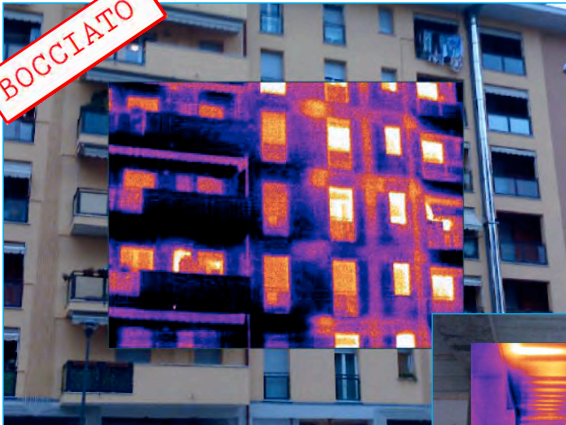
Edificio residenziale, facciata principale
