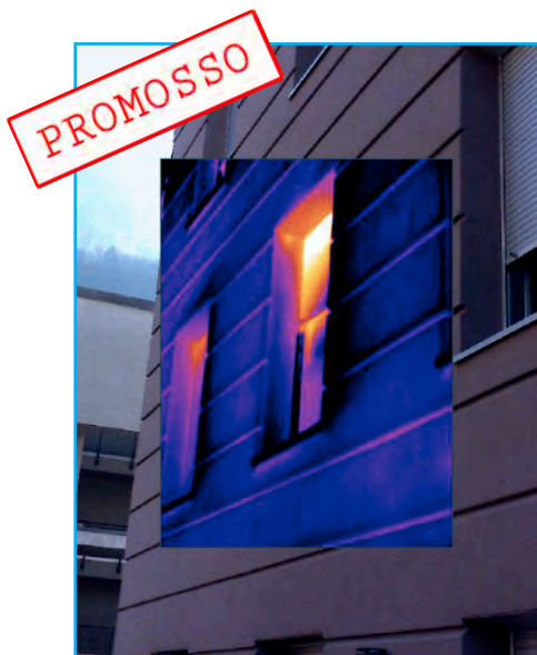
Dettaglio facciata nord est
