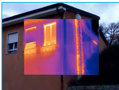
Particolare sede Comune
