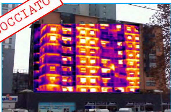
Edificio residenziale, facciata Sud Sud-Ovest
