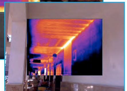
Solaio portico esterno facciata Est
