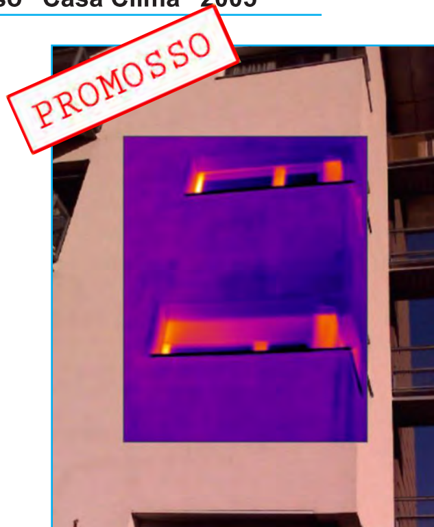
Facciate sud ovest
