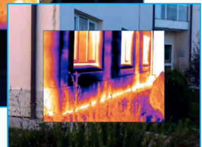
Particolare perimetro esterno
