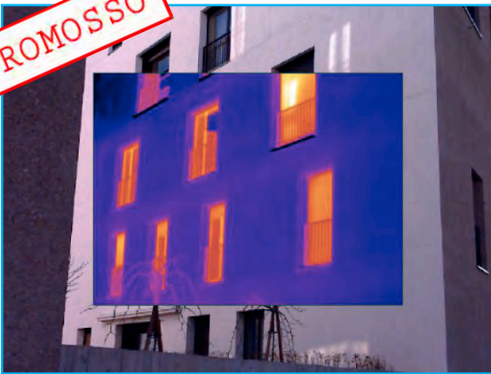
Dettagli facciata nord-est
