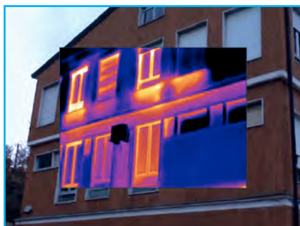
Particolare sede Comune
