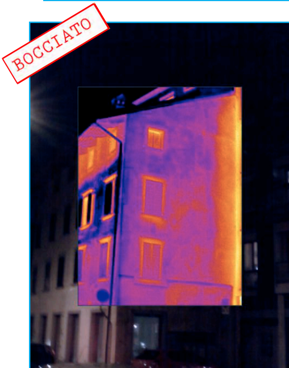
Particolare della facciata fronte strada, angolo sud est
