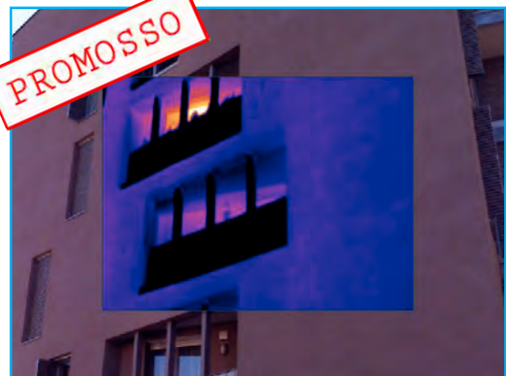
Dettagli facciata nord-est
